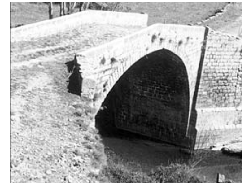
Puente de Sta. Bárbara, en el camino viejo de Préjano
