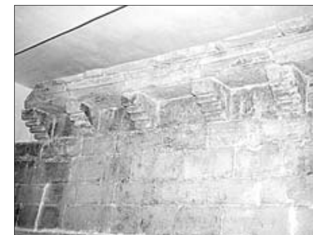
Canez, tejazoz y muro de la nave de la epístola, visto desde el claustro
